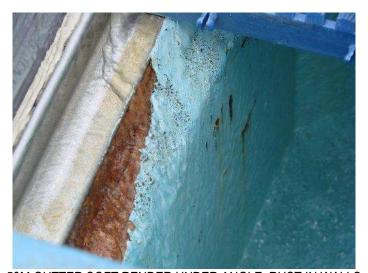
50M GUTTER SOFT RENDER UNDER ANGLE, RUST IN WALLS
