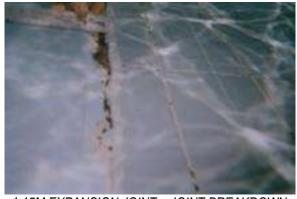
1.15M EXPANSION JOINT - JOINT BREAKDOWN
