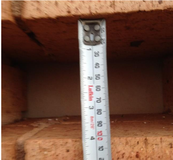
Depth for Single and Double Niche openings 225mm (D)
