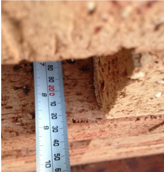
Depth for Single and Double Niche openings 225mm (D)
